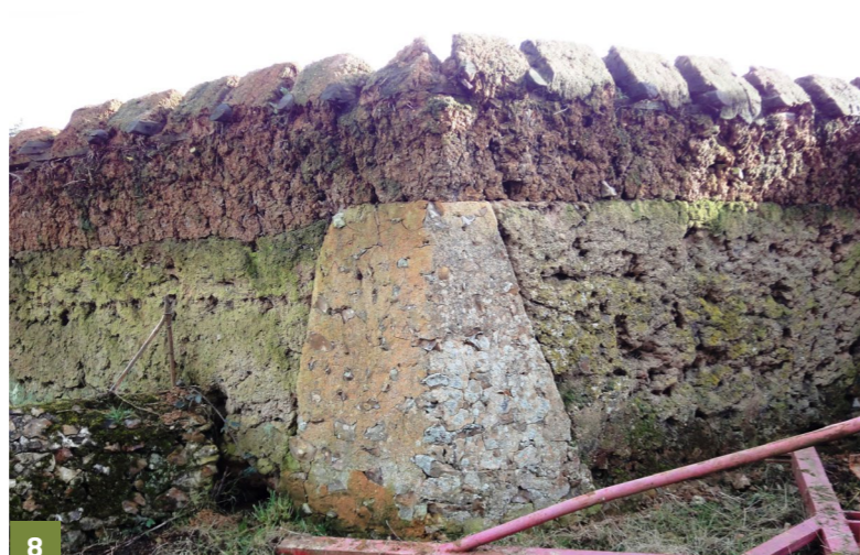
8 Le mur de clôture en pisé du château de la Rivière à Pontgouin (Eure-et-Loir). Seul l'angle est en maçonnerie. À noter également, les vestiges du chapeau en bois et en tuiles plates qui protégeait le sommet du mur de la pluie. © S. Bryant, Inrap.
