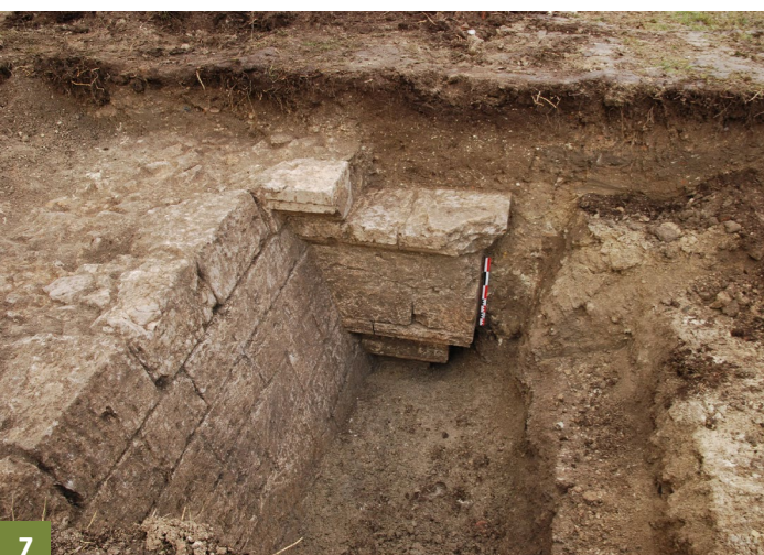
7 Vue générale des vestiges du mur d'escarpe avec un balcon en encorbellement qui délimitait les fausses braies du château de Chambord, découverts en 2010. © S. Bryant, Inrap.
